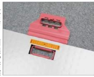
写真2 剥離や衝撃から保護するためにロックカバードカポクリップで覆うように装着
